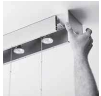
Inserimento dei tappi di chiusura Locking caps assembly
