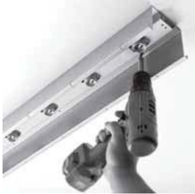
Collegamento elettrico e fissaggio della barra Electrical connection and bar fastening
