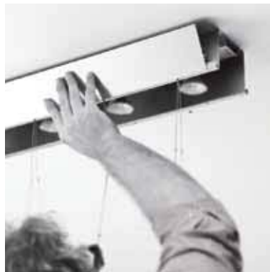
Posizionamento della fascia di rivestimento Cover assembly
