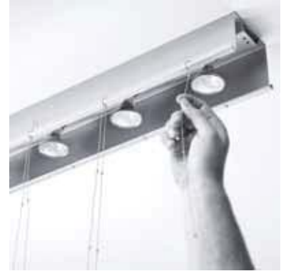
Inserimento dei cavi e loro taglio a misura Stainless steel cables insertion and cut
